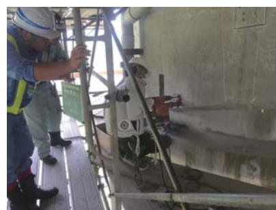
ドリル削孔試料採取例①
